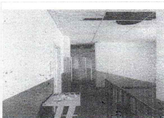
VISTA DA ÁREA DE CIRCULAÇÃO DO 2º PAVIMENTO
